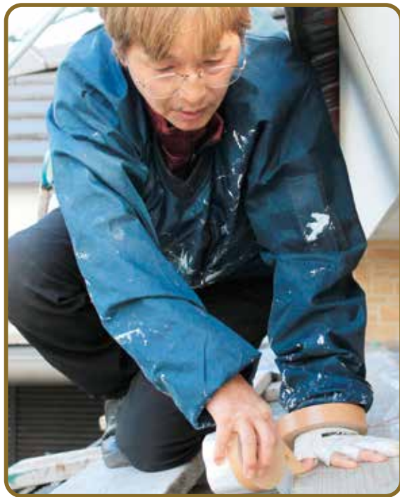
(写真) 塗装前の養生処理
